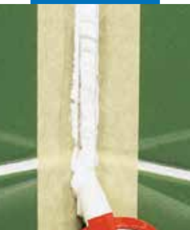
Aanbrengen van Mapesil AC
