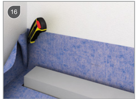
16 Uitsnijden van het hoekdeel in de waterdichtingsmat / Cutting out the corner part in the waterproofing mat / Découper le tapis imperméable au niveau des coins / Das Eck aus dem Dichtungsvlies ausschneiden
