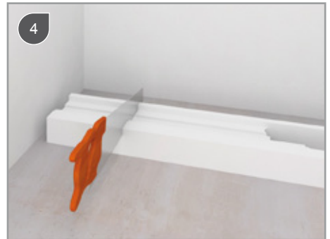
Installatieblok op maat versnijden indien nodig / If necessary cut the polystyrene installation block on the requested dimension / Coupez le bloc d'installation sur la mesure demandée si neces- saire / Schneiden Sie den Polystyroblok auf das benötigte Rinnenmaß zu.
