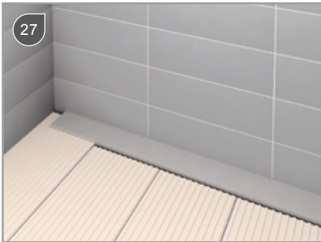
Tegellijm (EN 12004 C2) uitstrorijven / Spread of the tile adhesive (EN 12004 C2) / Appliquer de la colle à carrelage (EN 12004 C2) / In der Duschfläche auf das Dichtungsvlies Flexkleber aufziehen
