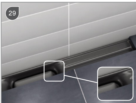
Tegelblok wegnemen / Remove the tile profile / Enlever le guide de pose en polystyrène / Styropor Rinnen Innenteil rausnehmen
