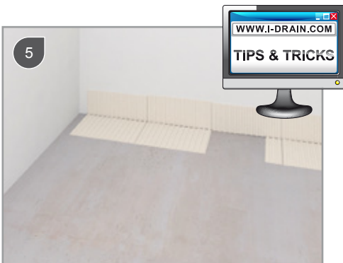
Tegellijm (EN12004C2) uitstrijken/Spread of the tile adhesive (EN 12004 C2)/Appliquer de la colle à carrelage (EN 12004 C2)/ Flexkleber EN 12004 C2 aufziehen
