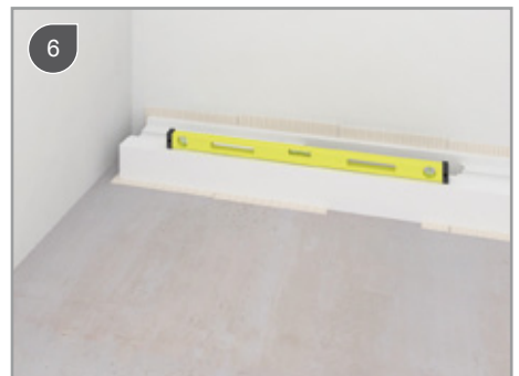
Installatieblok waterpas stellen / Horizontal positioning of the polystyrene installation block / Positionnement horizontal du bloc d'installation / Den Polystor Installationsblok waagrecht ausrichten
